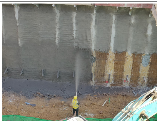
石门路站桩间混凝土喷射施工
