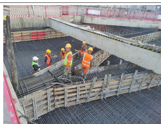
石门路站顶板钢筋绑扎施工
