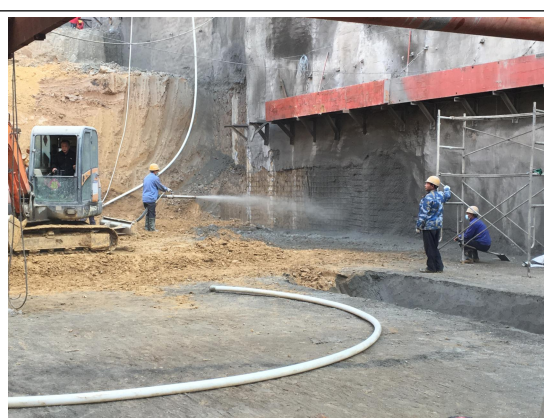
天都路站桩间喷射混凝土施工
