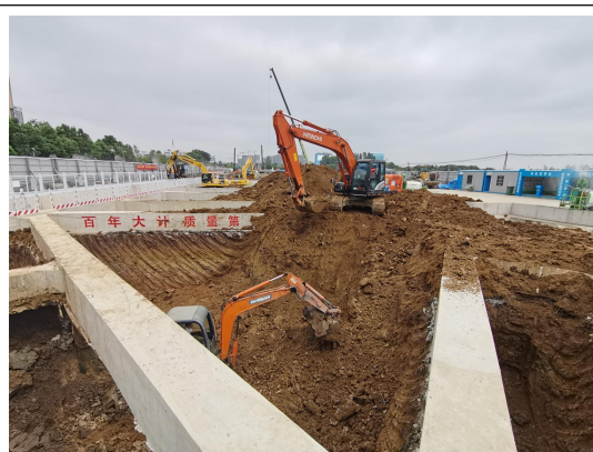
天都路站土方开挖施工
