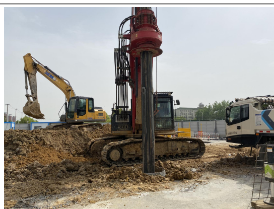
耕耘路站围护桩施工
