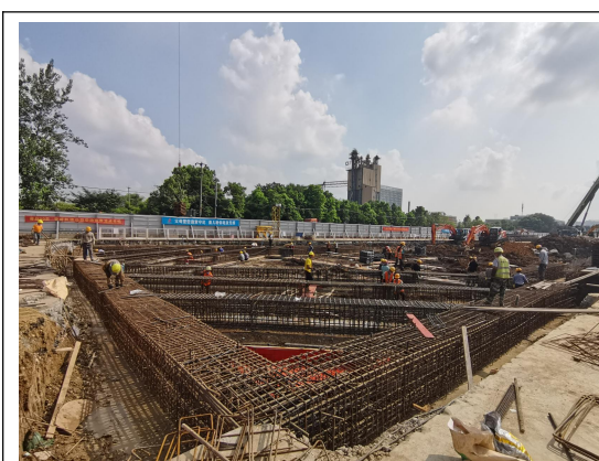
天都路站冠梁及混凝土支撑钢筋绑扎施工
