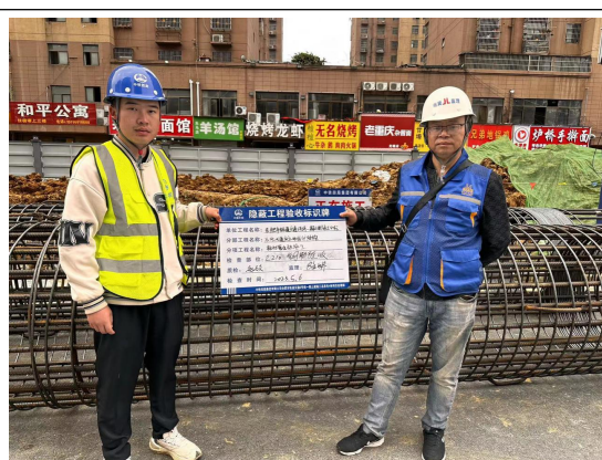
东风大道站钢筋笼验收
