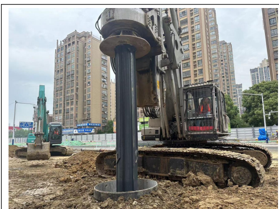
东风大道站桩基施工
