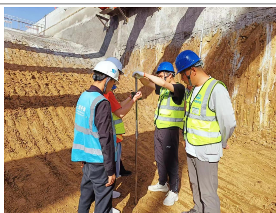
基底复测--出入场线
