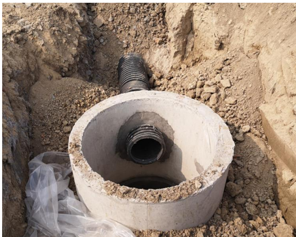
图 钢筋混凝土检查井
