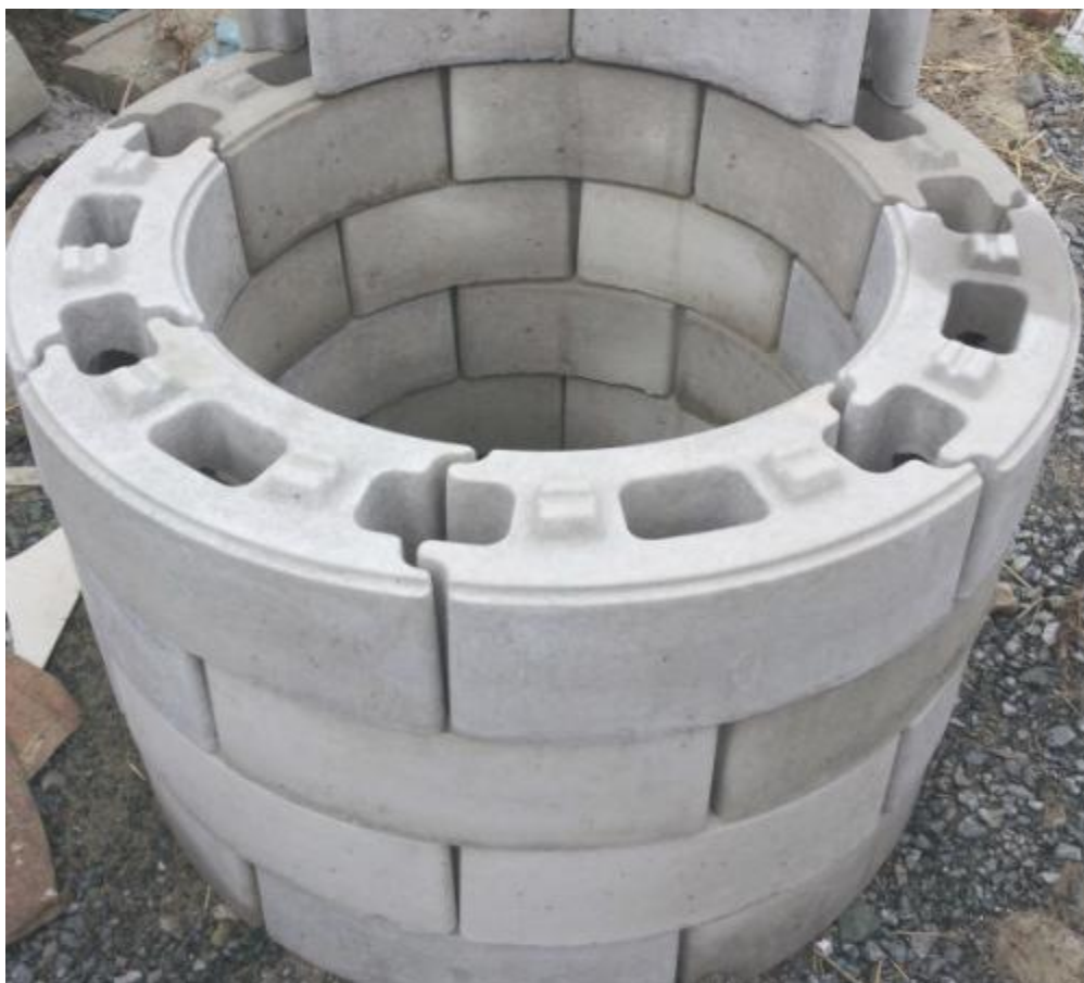
图 混凝土模块式检查井
