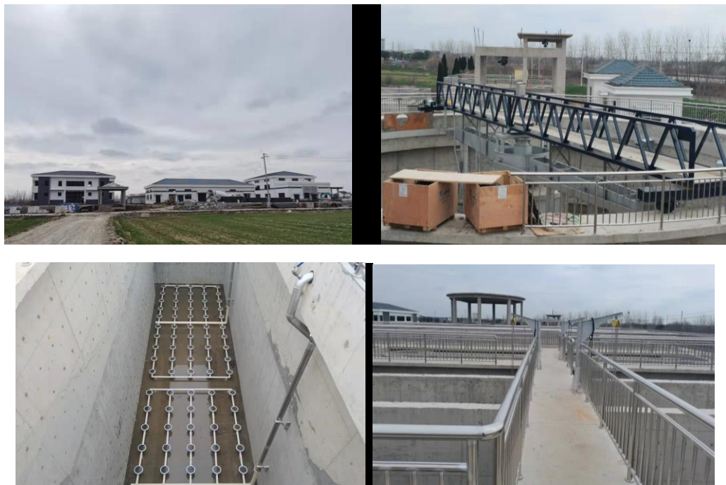
图 射阳湖镇新污水处理厂建设现状图
