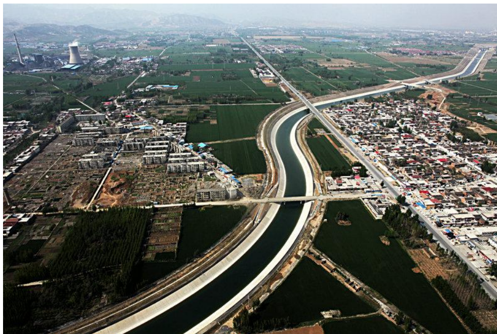
南水北调中线工程鸟瞰
