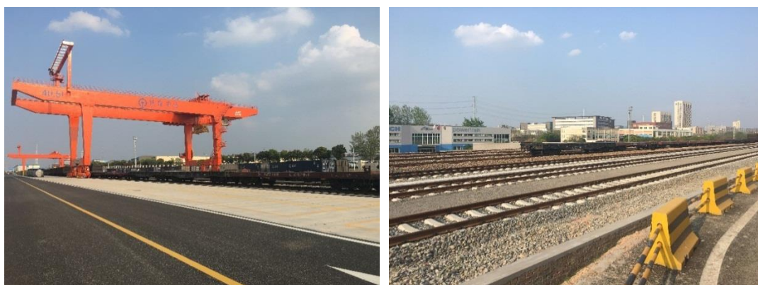
新建尧化门铁路货场
