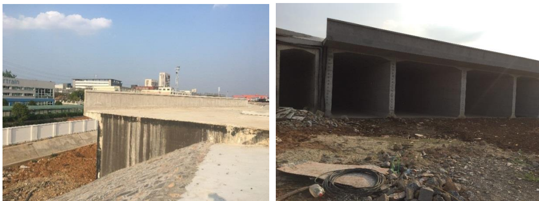
已建隧道暗埋段
