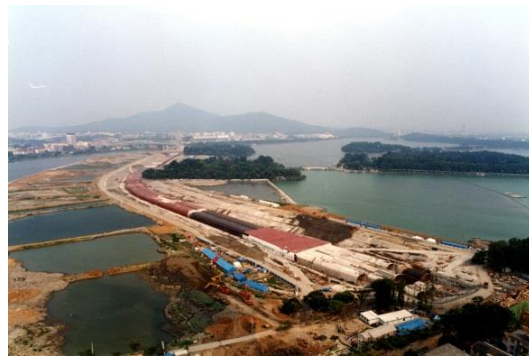
南京玄武湖隧道围堰明挖施工现场照片
