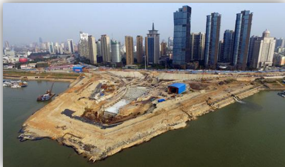
南昌红谷隧道围堰明挖施工现场照片
