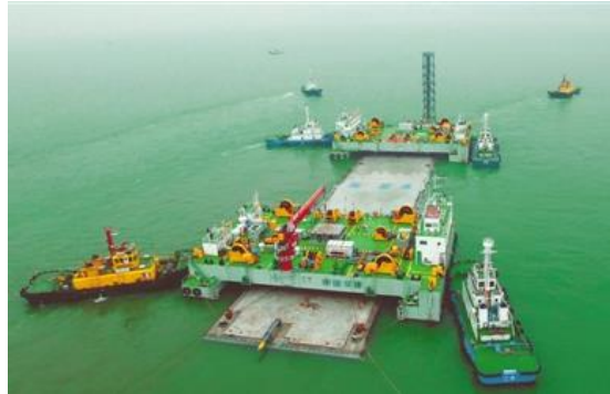
港珠澳隧道沉管施工现场照片
