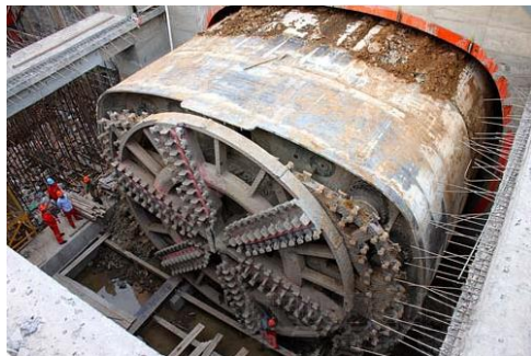
下穿中州大道纬四路顶管隧道 施工现场照片
