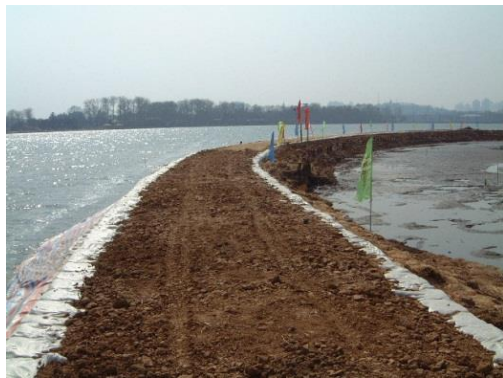
南昌红谷隧道围堰明挖施工现场照片
