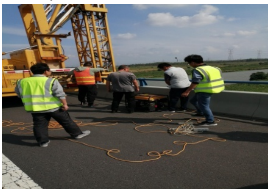
e)入海水道、灌溉总渠大桥工作照片
