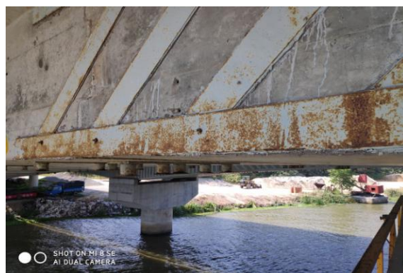
图 1-4 48#~50#钢板锈蚀
