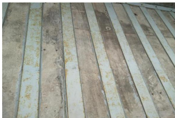
图 1-8 8#~14#钢板锈蚀
