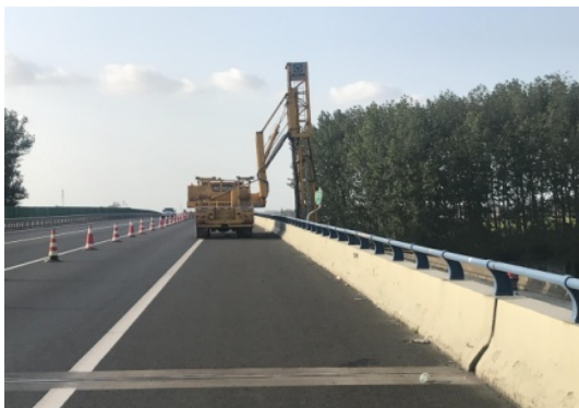
a)新洋港大桥现场照片
