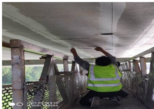
d)黄沙港大桥底板工作照片
