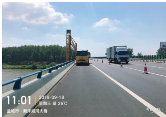
b)新洋港大桥现场照片
