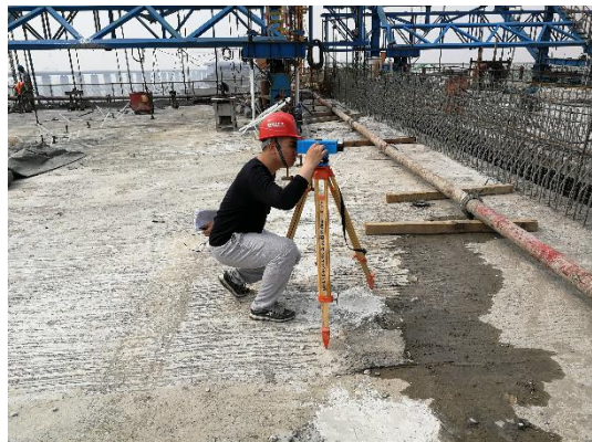
图 1-4 现场标高数据测量
