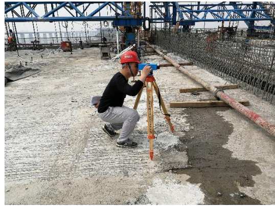
图 F1-4 现场标高数据测量
