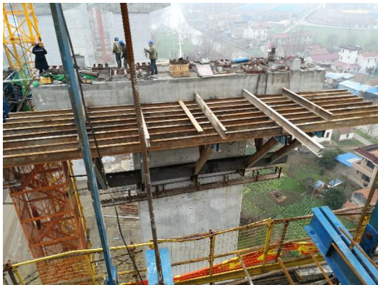
图 1-1 边跨现浇段托架施工
