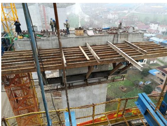
图 F1-1 边跨现浇段托架施工
