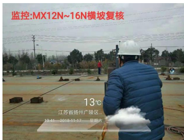
附图 1.0-24 北岸第三批下层桥面系 (MX12~MX16) 预拼装线形复测
