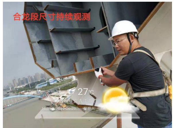
附图 1.0-51 拱肋合龙段尺寸观测
