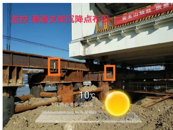
附图 1.0-15 南岸 Z7 主桁梁节段拖拉滑移过程监测
