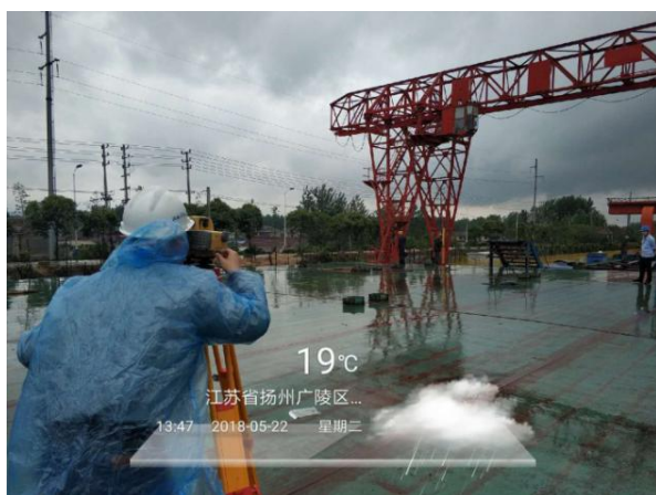
附图 1.0-4 测量桥面系 MX1~MX6 节段（第一批）预拼装的线形及横坡
