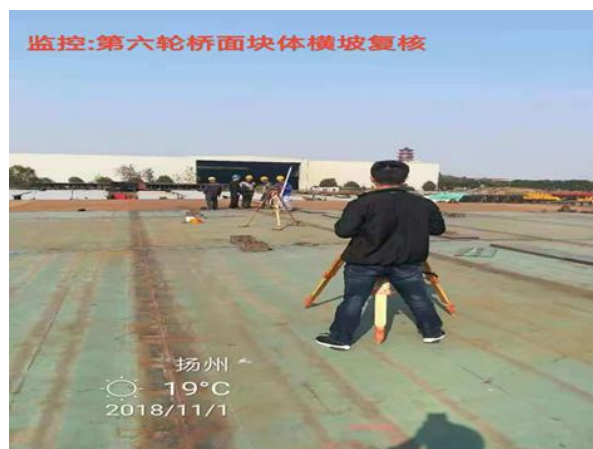
附图 1.0-21 南岸第二批上层桥面系 (MS7~MS11) 预拼装线形复测
