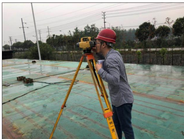
附图 1.0-8 测量桥面系 MX1~MX6 节段（第二批）预拼装的线形及横坡
