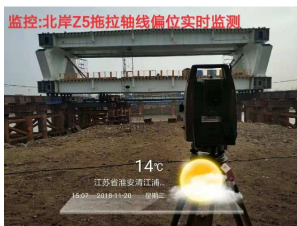
附图 1.0-26 北岸 Z5 主桁梁节段拖拉滑移过程监测
