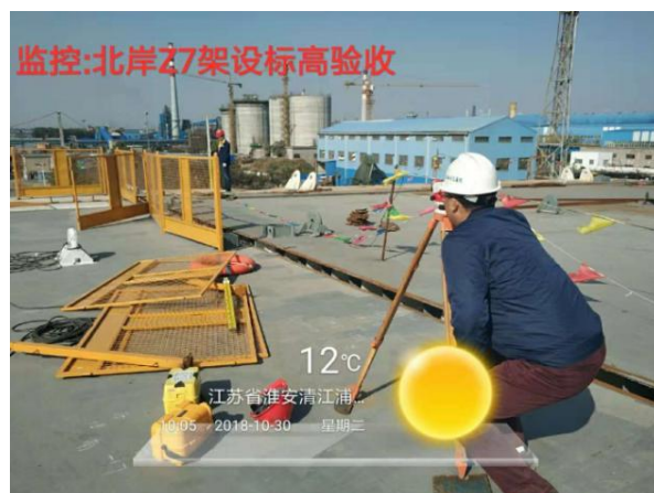
附图 1.0-19 北岸 Z7、Z6 主桁梁节段轴线、高程精确调整与对接
