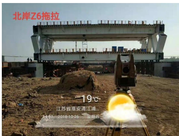
附图 1.0-16 北岸 Z6 主桁梁节段拖拉滑移过程监测
