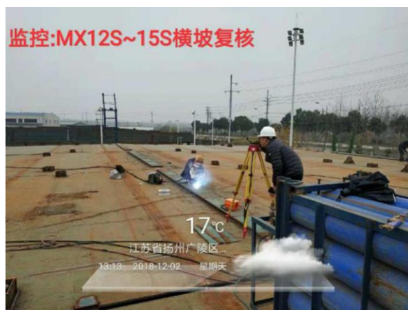
附图 1.0-30 Z0 节段（南岸侧）下层桥面系预拼装线形复测（MX12~MX15）
