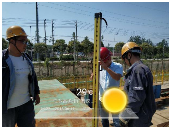
附图 1.0-7 测量桥面系 MS1~MS6 节段（第二批）预拼装的线形及横坡
