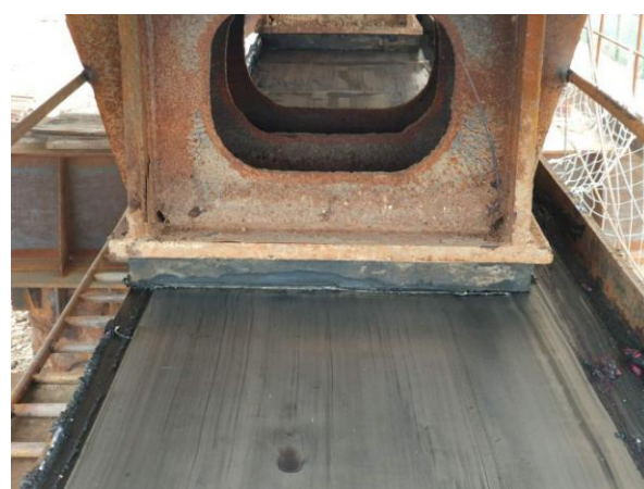
附图 1.0-29 北岸 Z5 主桁梁节段拖拉滑移过程中 偏移卡顿
