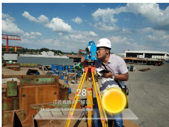
附图 1.0-10 南岸第一批主桁梁预拼装线形复测（Z7~Z5 节段）
