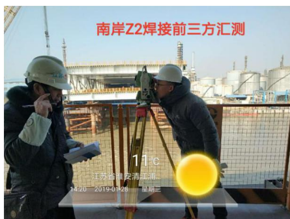
附图 1.0-38 焊接前三方汇测验收
