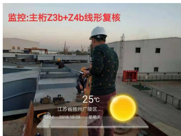
附图 1.0-18 南、北岸右侧主桁梁 Z4~Z3 节段预拼装线形复测
