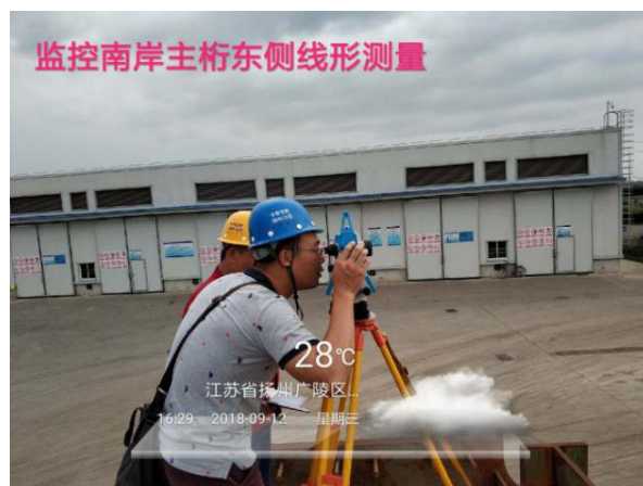
附图 1.0-11 南岸第二批主桁梁预拼装线形复测（Z7~Z5 节段）
