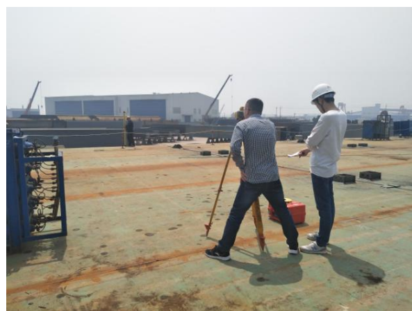
附图 1.0-3 测量桥面系 MS1~MS6 节段（第一批）预拼装的线形及横坡
