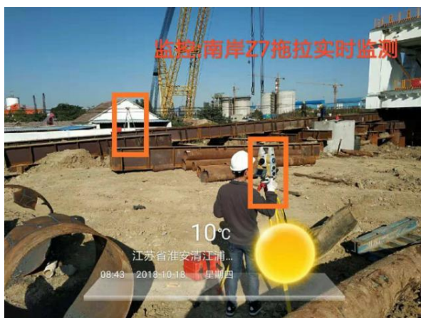
附图 1.0-15 南岸 Z7 主桁梁节段拖拉滑移过程监测
