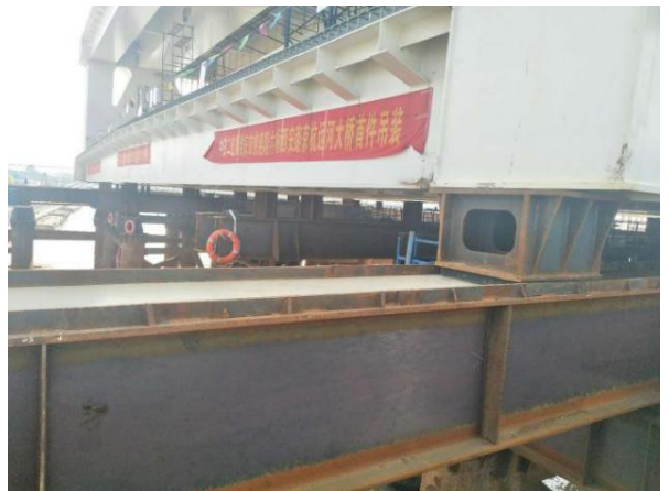
附图 1.0-13 北岸 Z7 主桁梁节段拖拉滑移过程监测
