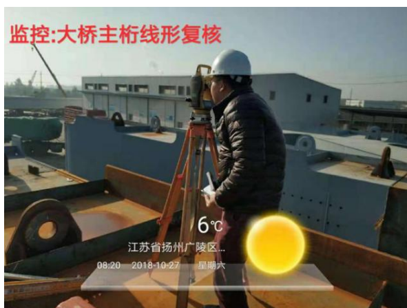
附图 1.0-17 南、北岸左侧主桁梁 Z4~Z3 节段预拼装线形复测
