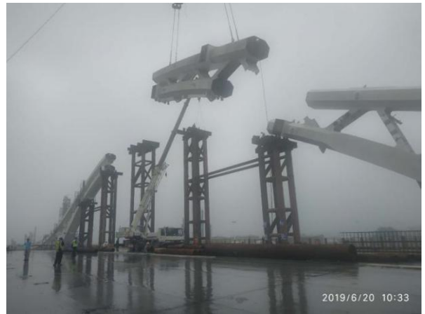
附图 1.0-49 主拱圈吊装
