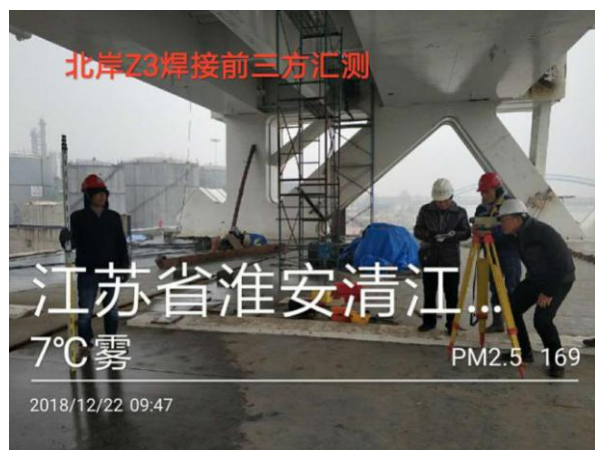
附图 1.0-33 北岸 Z3 焊接前三方测量验收
