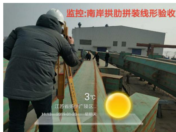
附图 1.0-37 边跨拱肋拼装线形验收（宝桥工厂）
