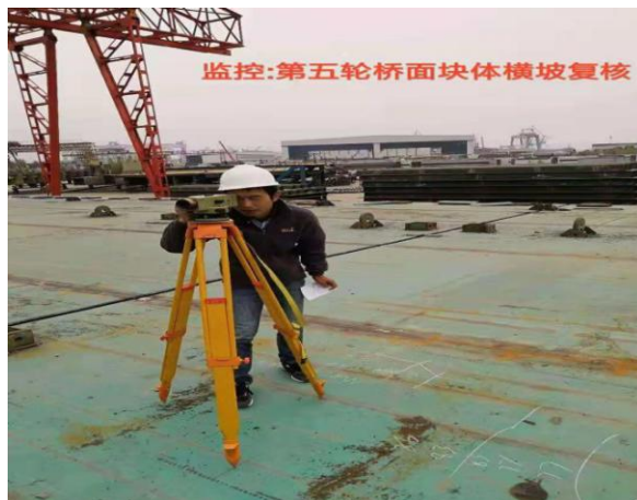
附图 1.0-14 北岸第二批下层桥面系 (MX7~MX11) 预拼装线形复测
