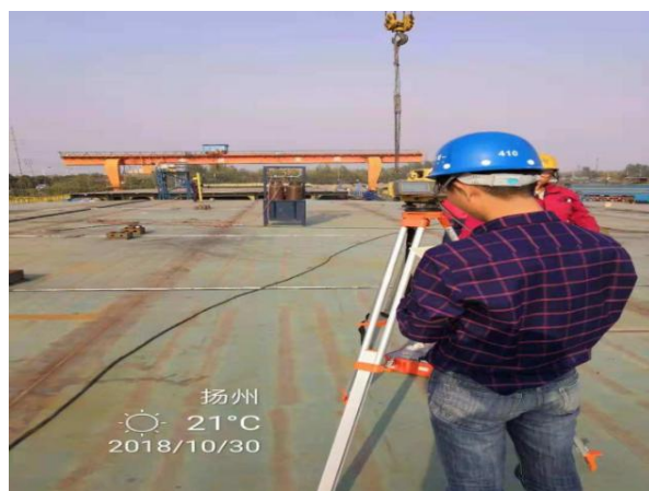
附图 1.0-20 南岸第二批下层桥面系 (MX6~MX11) 预拼装线形复测
