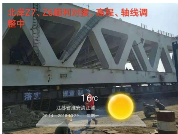
附图 1.0-19 北岸 Z7、Z6 主桁梁节段轴线、高程精确调整与对接
