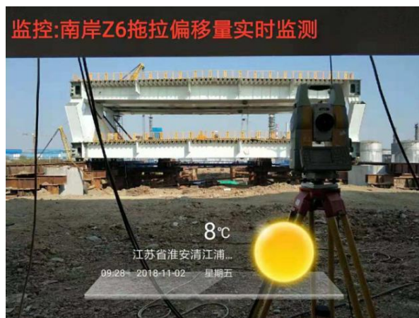
附图 1.0-22 南岸 Z6 主桁梁节段拖拉滑移过程监测
