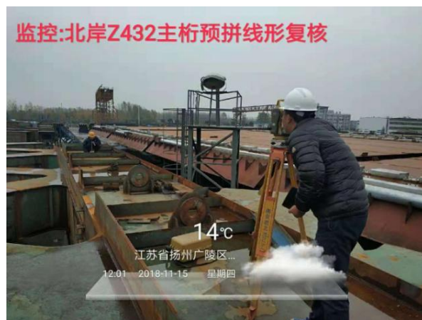
附图 1.0-23 北岸右侧主桁梁 Z4+Z3+Z2 节段预拼装线形复测
