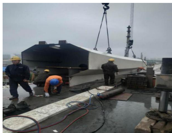
附图 1.0-46 主拱圈吊装
