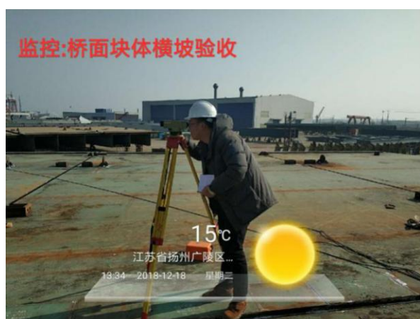
附图 1.0-32 Z0 节段（南岸侧）上层桥面系预拼装线形复测（MS12~MS15）
