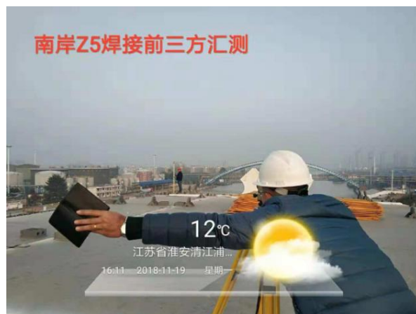
附图 1.0-25 南岸 Z5 焊接前三方测量验收
