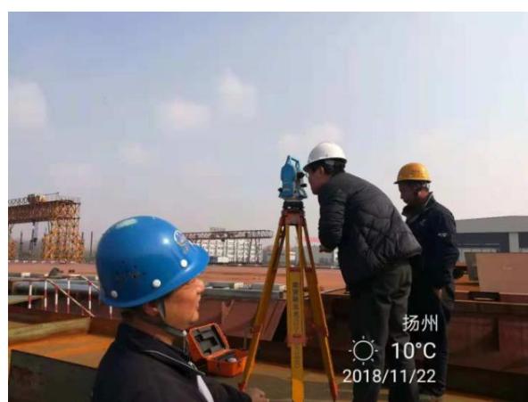
附图 1.0-27 北岸第三批上层桥面系 (MS12~MS16) 预拼装线形复测
