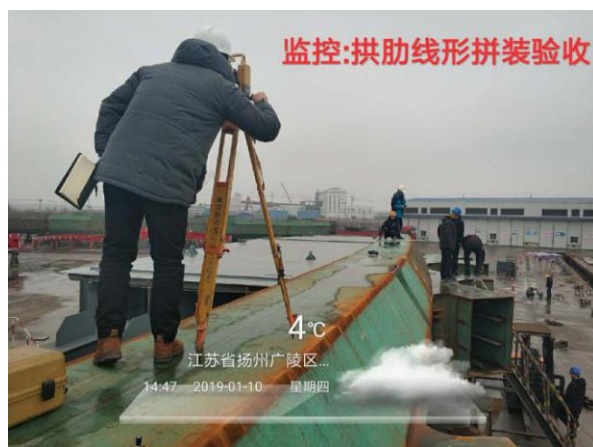
附图 1.0-36 拱肋拼装线形验收（宝桥工厂）
