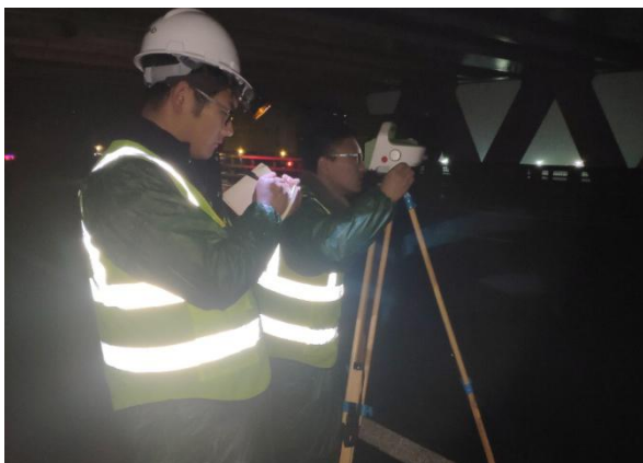
d) 桥面位移测试
