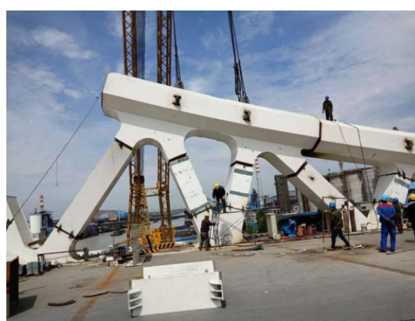
附图 1.0-47 主拱圈吊装
