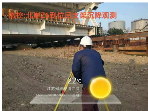
附图 1.0-16 北岸 Z6 主桁梁节段拖拉滑移过程监测
