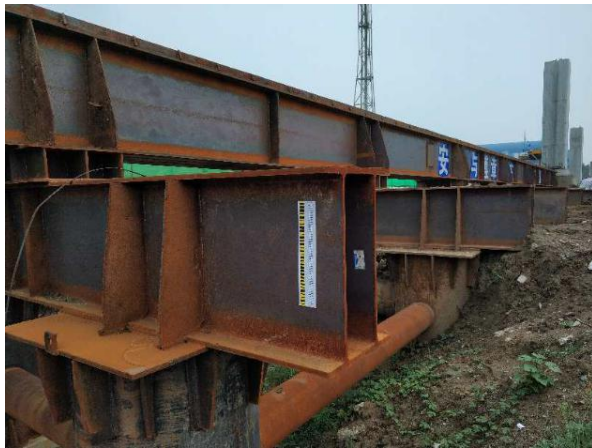
附图 1.0-12 北岸滑道支架监测点布设
