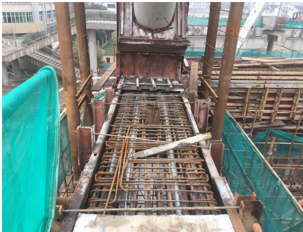
附 F2-2 混凝土浇筑
