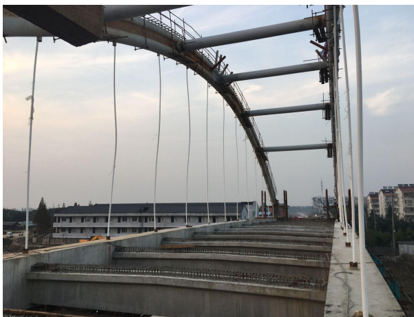
附 F2-2 吊杆安装
