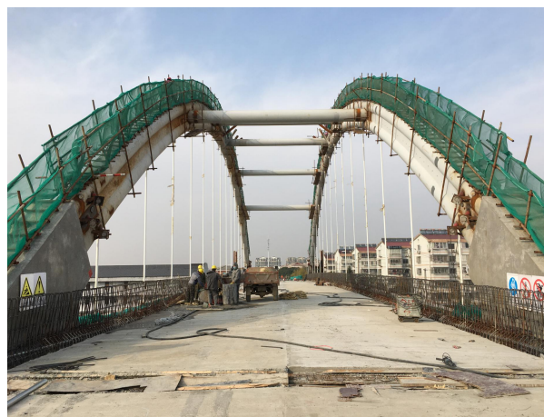
附 F2-4 调平层施工完成
