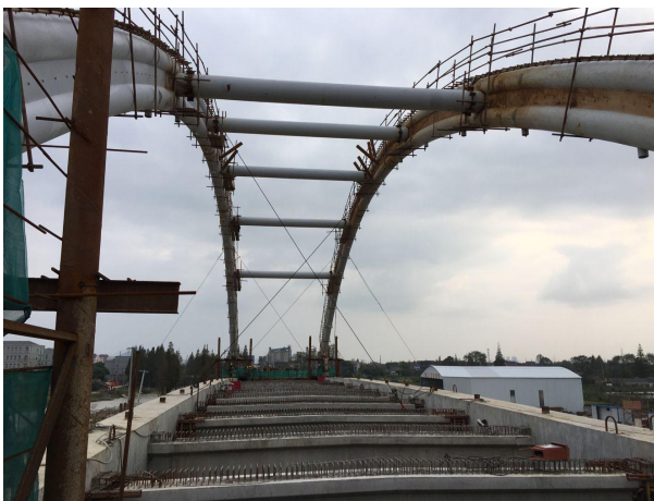
附 F2-1 中横梁架设完成
