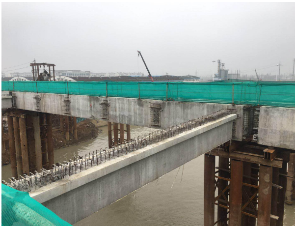
附 F2-1 中横梁架设完成
