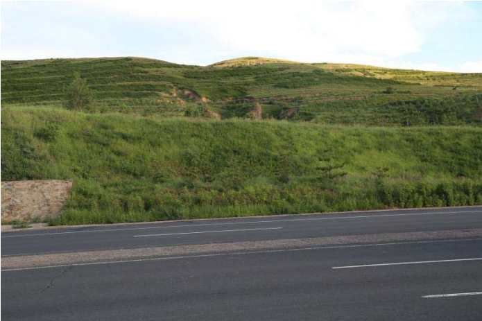
公路建设生态修复
