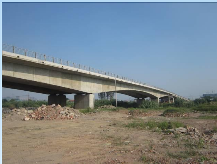
开元大桥主桥
