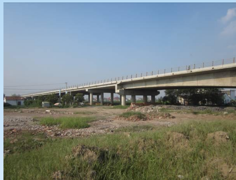
开元大桥引桥
