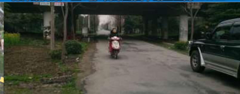
马坂路：7m乡道, 3x16m空心板梁桥，净高4.2m
