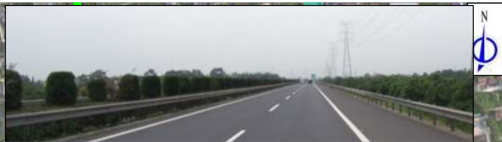
常合高速：双向4车道，设计车速120Km/h，路基宽度28m
