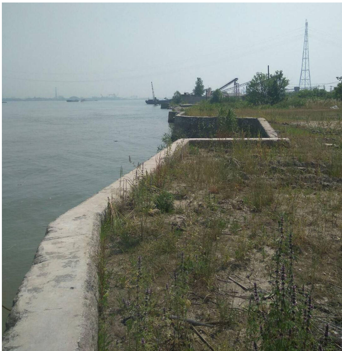
图4-2 水域现场图（拆迁后）
