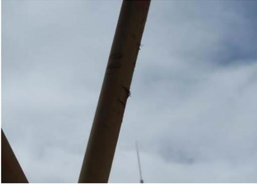
1) PE 护套轻微破损
