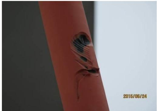
6) PE 护套重度破损 (钢丝外露)
