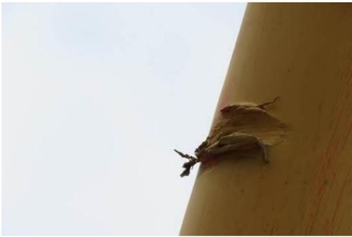
3) PE 护套中度破损
