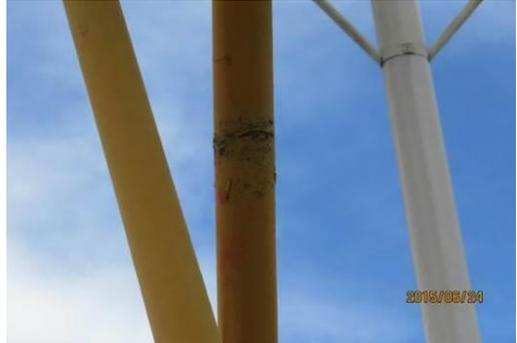
4) PE 护套中度破损
