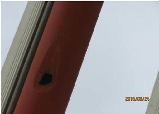
4) PE 护套重度破损 (钢丝外露)
