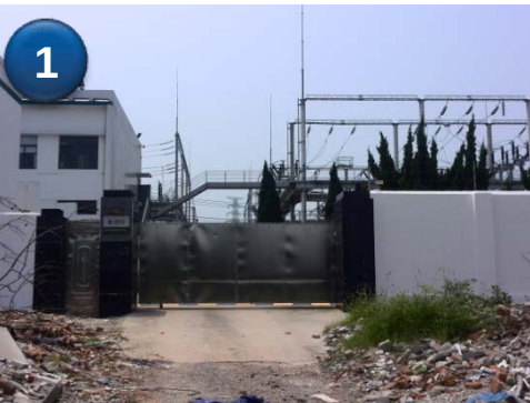
大定坊220kv变电站
