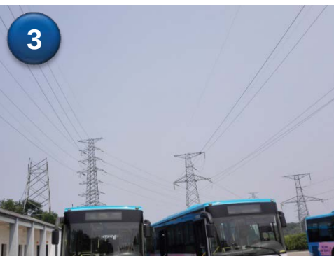
大周路北侧高压输电塔
