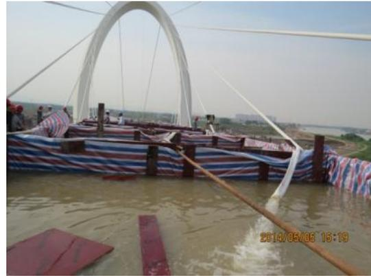
d) 静载试验水箱加载
