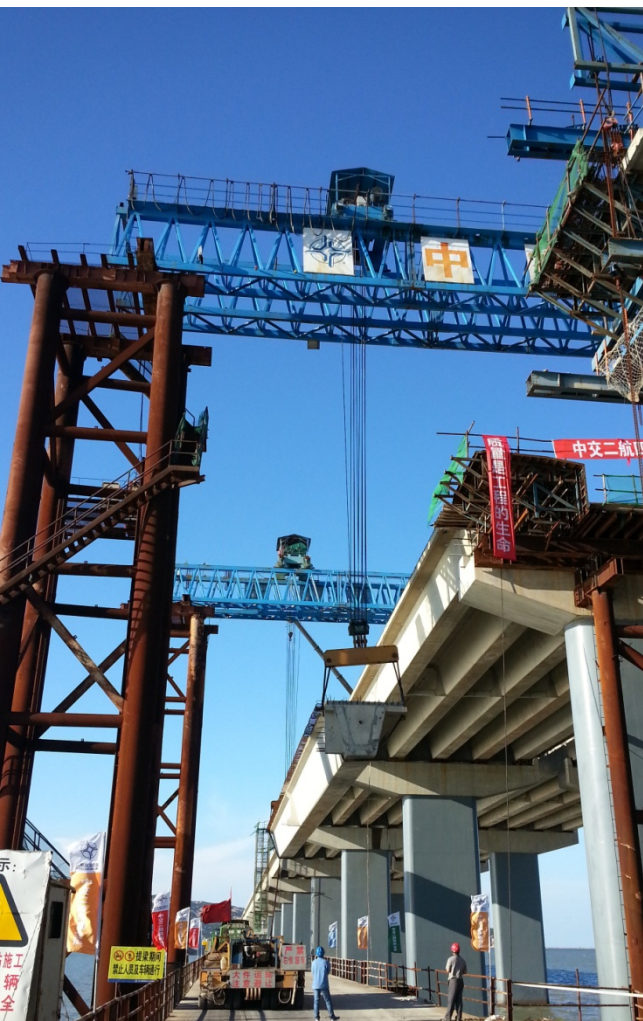
中引桥处提梁站
