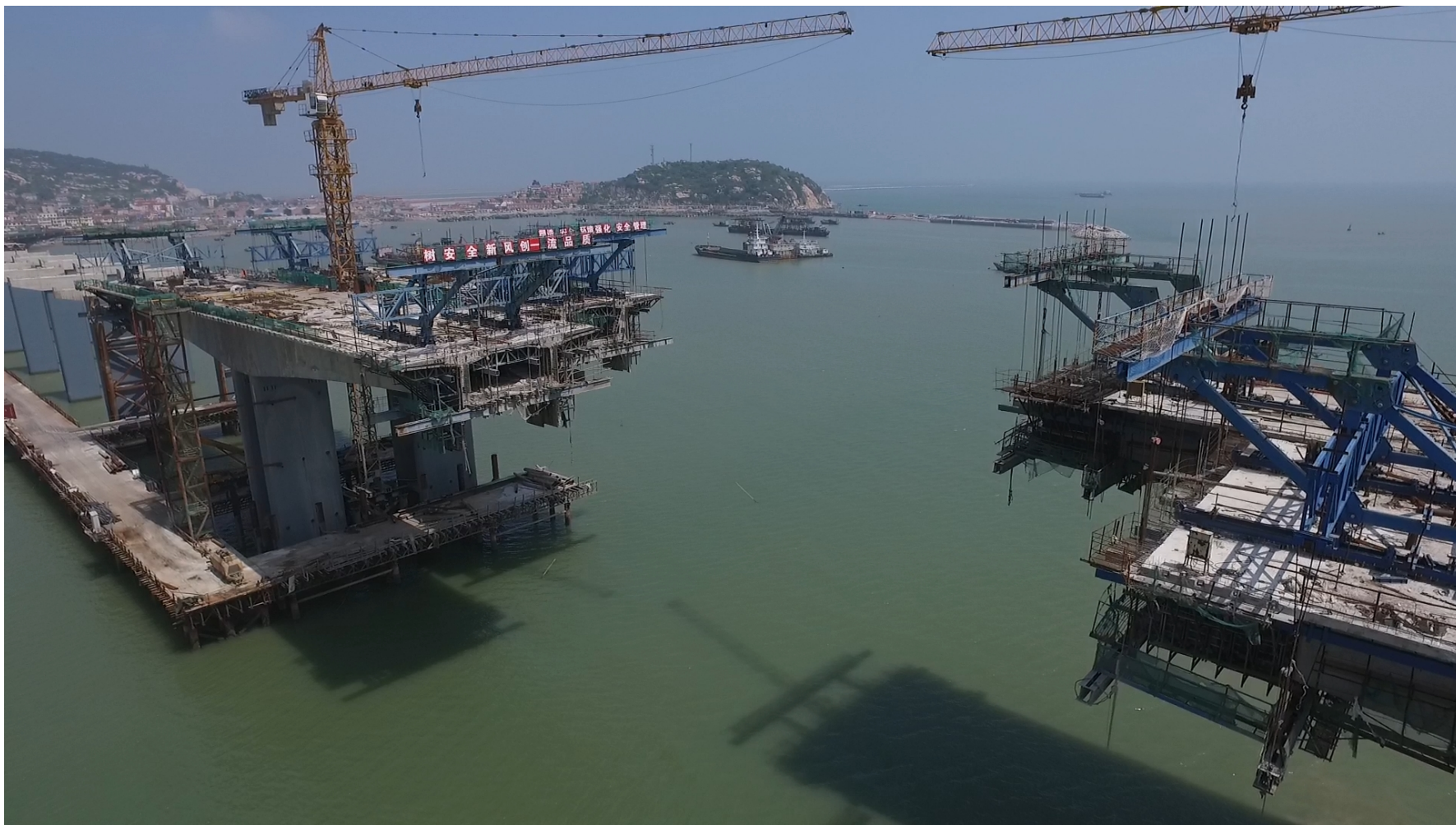
变截面预应力混凝土连续刚构箱梁悬浇施工
