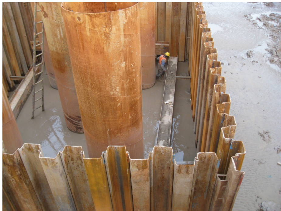
引桥钢板桩围堰
