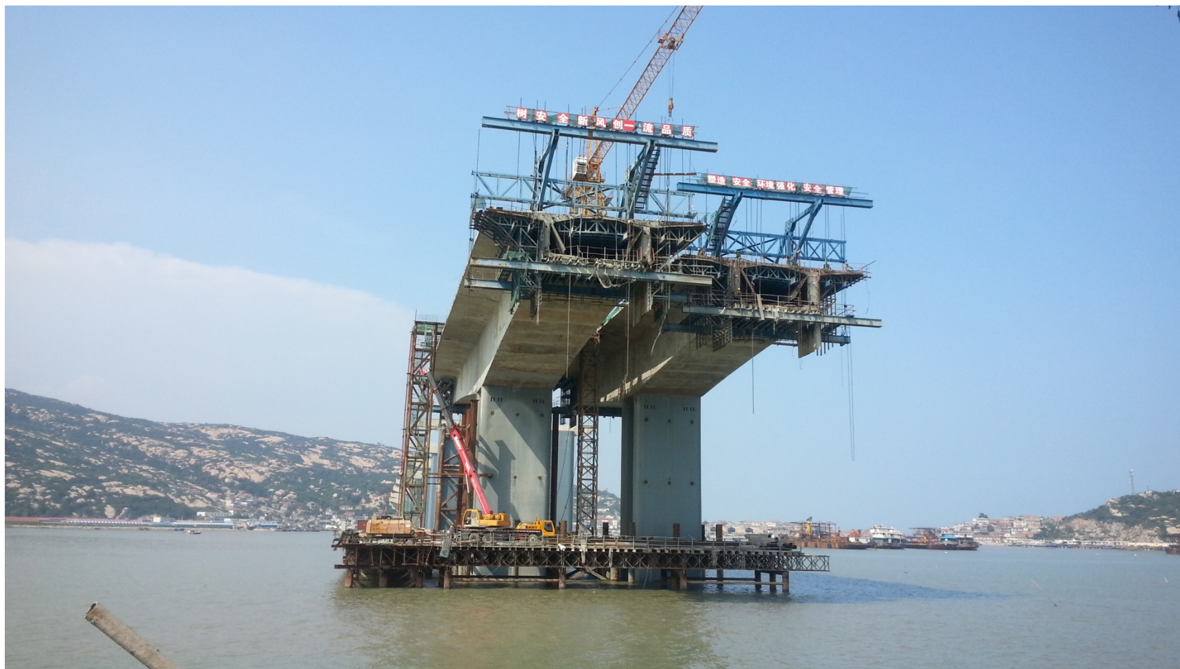
主通航孔桥悬浇施工
