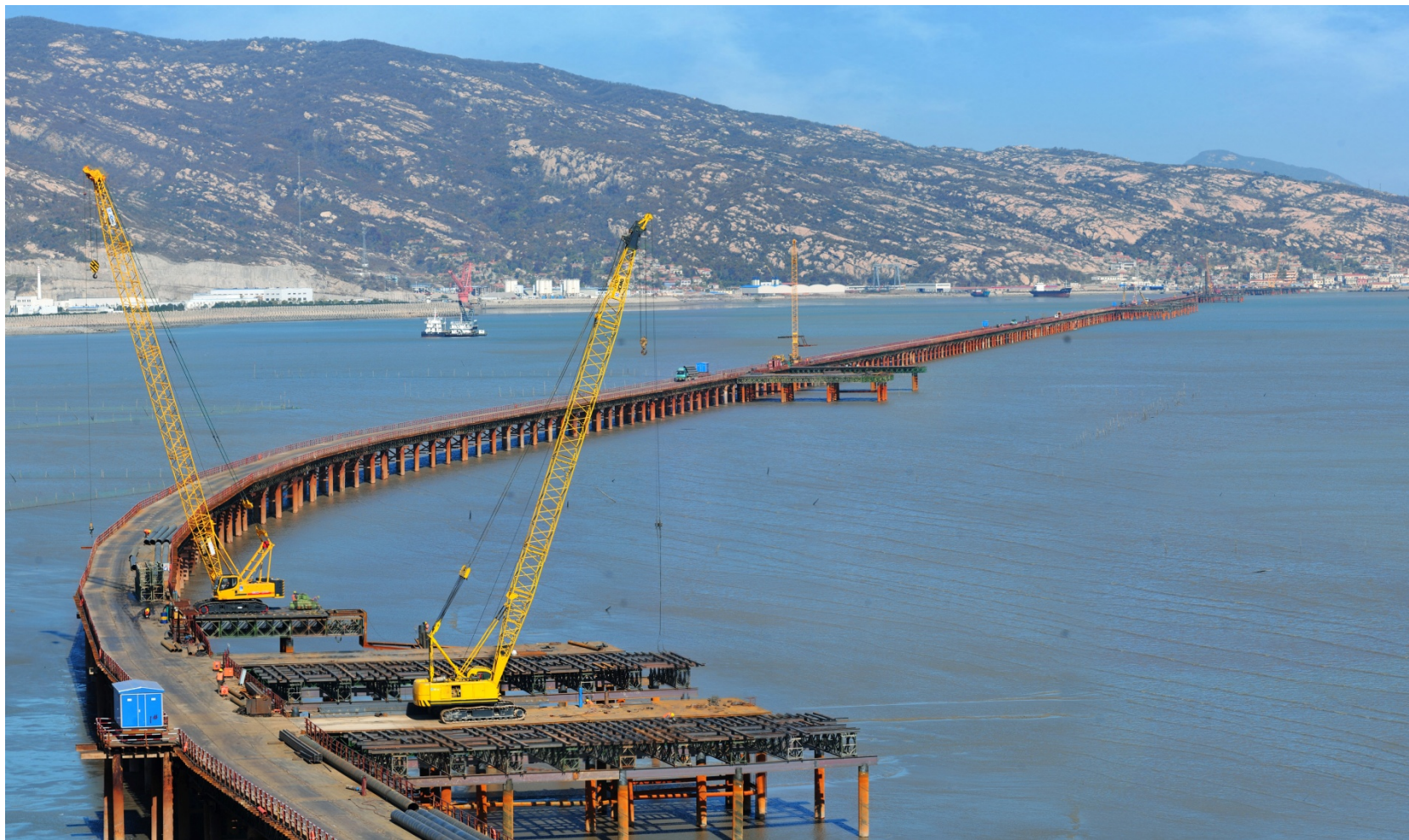
海上施工栈桥搭设
