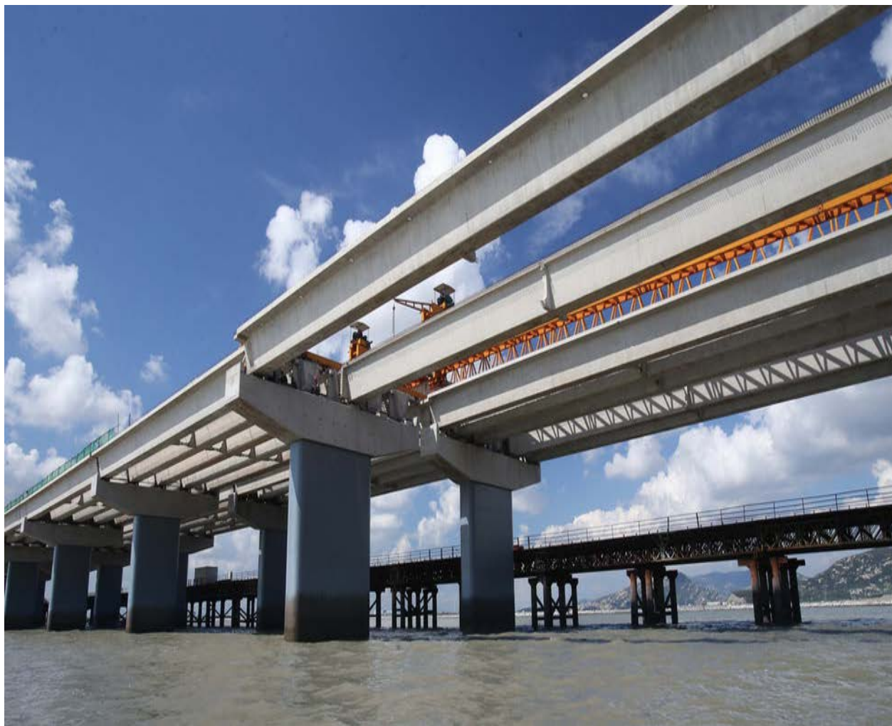
组合箱梁架设
