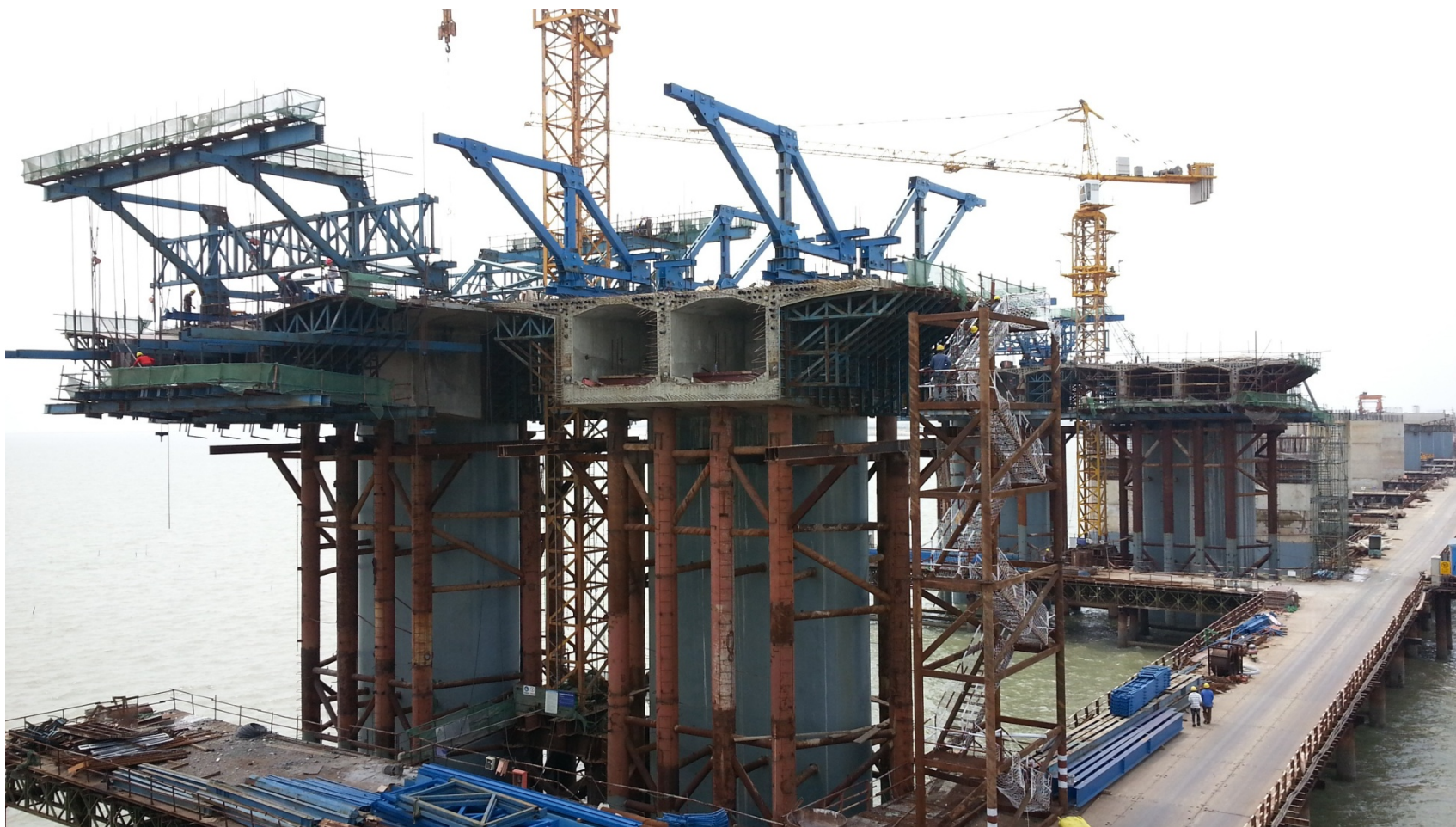
辅通航孔桥悬浇施工
