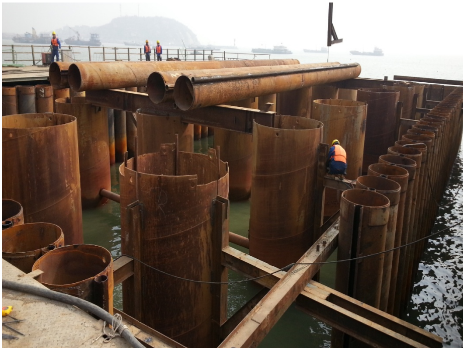
主桥CO锁口钢管桩围堰
