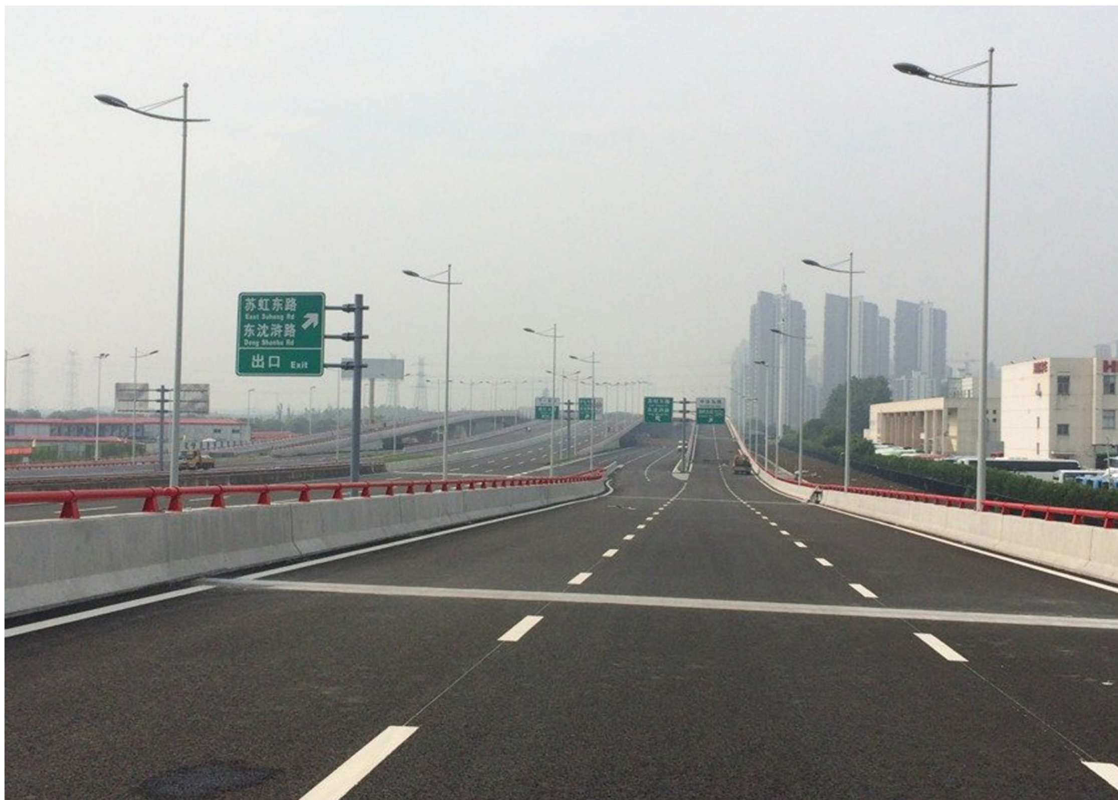
中环快速路园区段高架桥面人视实景照
