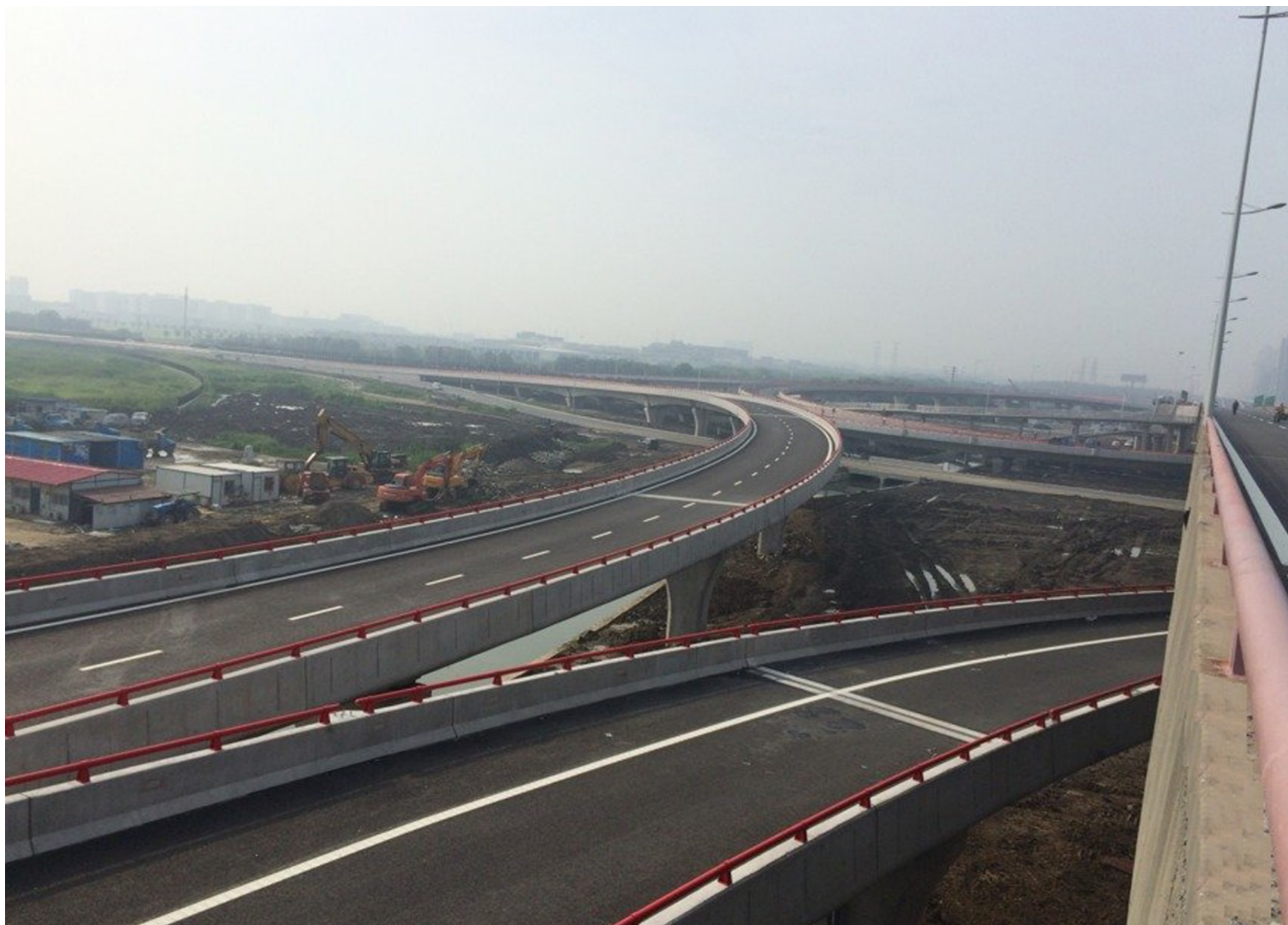
娄江立交匝道人视实景照
