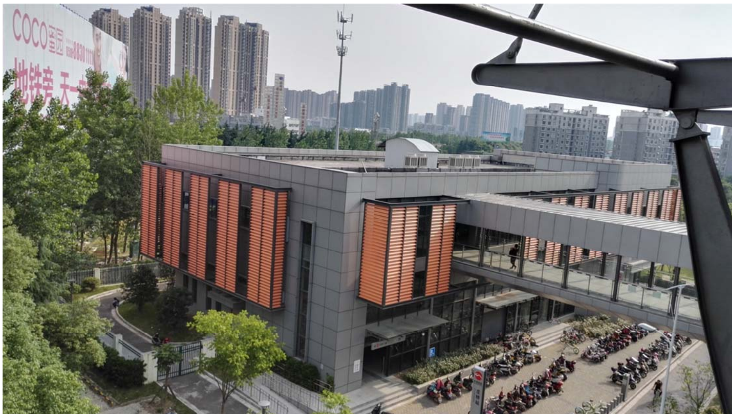
庄桥站（原春阳路站）实景图（三）
