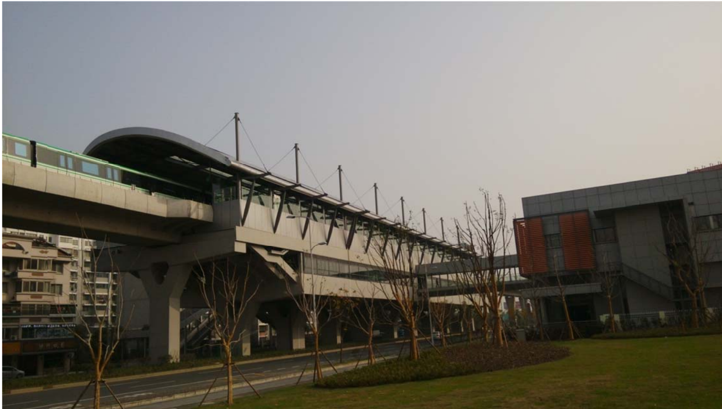
庄桥站（原春阳路站）实景图（一）
